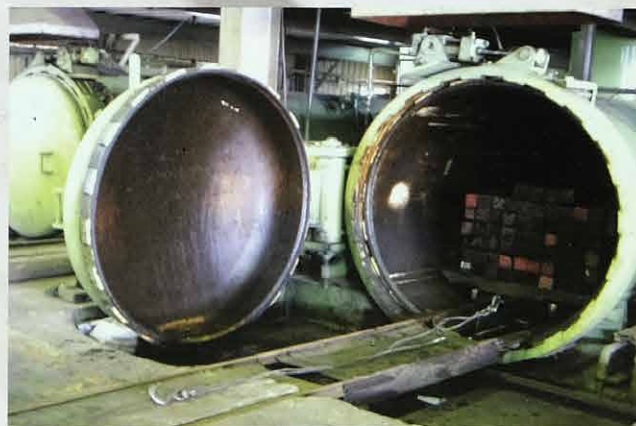
真空加壓完出槽
